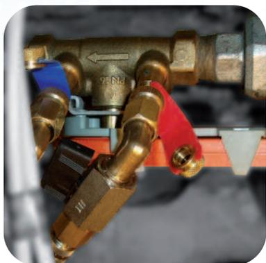
La valise de mesure proposée par SOGOBA vous permet une mesure précise de la perte de charge, du débit et de la température sur l'ensemble des vannes d'équilibrage du marché.
